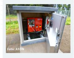
An einem Standort im Harz hat eine Box bereits die Möglichkeit zum Dauerbetrieb unter realen Bedingungen unter Beweis gestellt. Bei drei längeren Stromausfällen des Energieversorgers (hier sind sturmbedingt Bäume auf Stromleitungen gefallen) hat die NEA-Box den Standort über insgesamt 380 Stunden ohne Probleme mit Notstrom versorgt. Das System hat sich somit bereits unter realen Bedingung bewährt.
