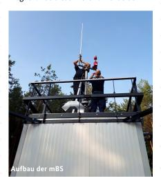
Weitverkehrstrupp des Ortsverbandes Potsdam der Bundesanstalt Technisches Hilfswerk (THW) angefordert. Mit dessen Mastkraftwagen konnte die TETRA-Antenne in einer Höhe von 40 Metern installiert und dadurch eine Verbesserung der Funkversorgung im Waldbereich erzielt werden. Im weiteren Einsatzverlauf wurde die mBS der Polizei Berlin aus dem Einsatz herausgelöst und durch die mBS der Bereitschaftspolizei Brandenburg ersetzt.
