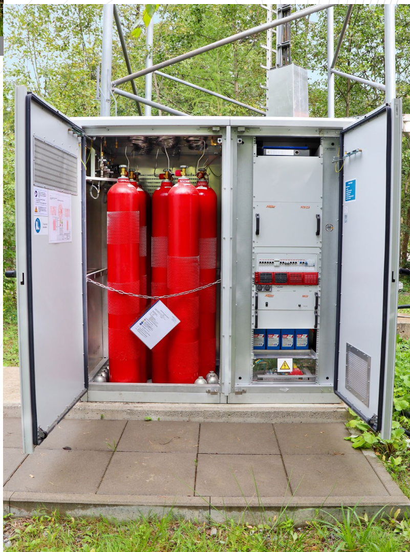
wasserstoffbetriebene Netzersatzanlage
