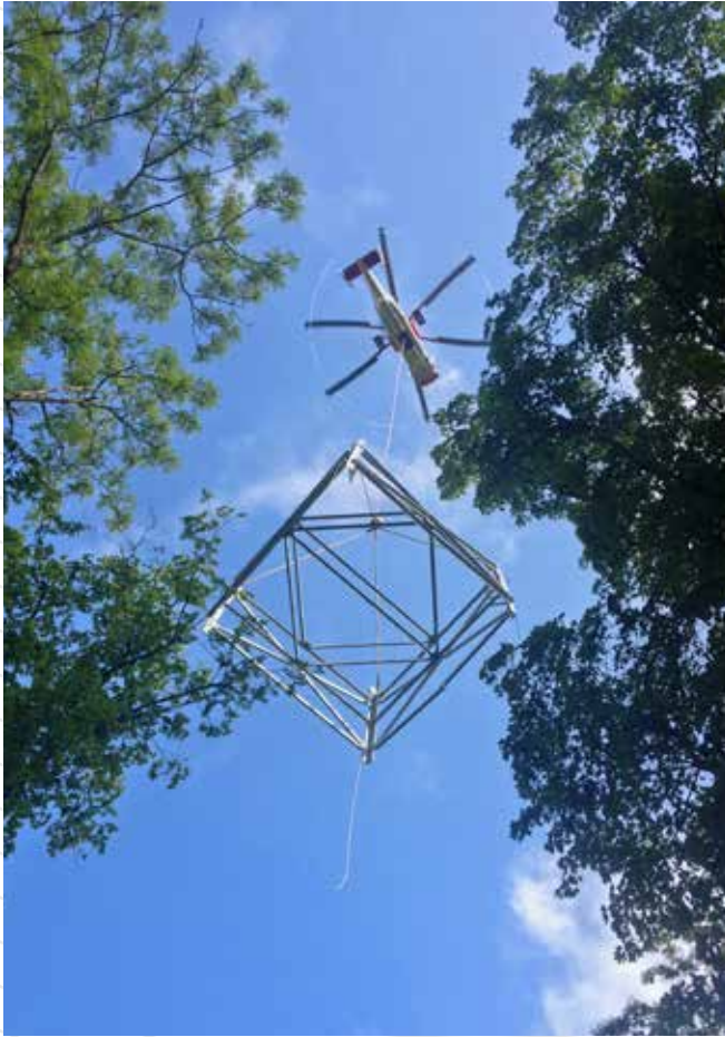
Aufbau eines Antennenmastes mit Hilfe eines Hubschraubers.
