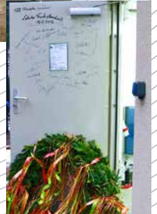
Fertigstellung der letzten Basisstation am 19.12.2012, Bild: ASBB.
