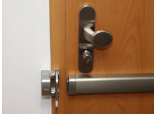
^ Querriegelschloss mit Sperrbügel
